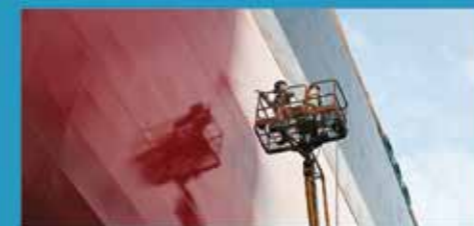
ПОКРАСОЧНЫЕ И ЗАЧИСТНЫЕ РАБОТЫ
