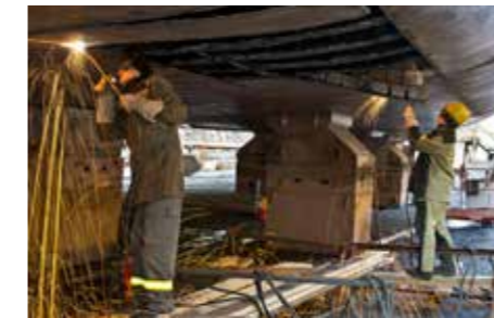
Организация любых судоремонтных работ
