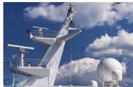
Техническое обслуживание радионавигационного и передающего оборудования
