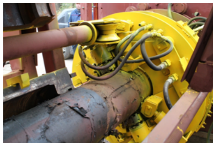
Рисунок 2 – Механизм зачистки трубы
