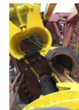
Предварительная ремонтная гильза
