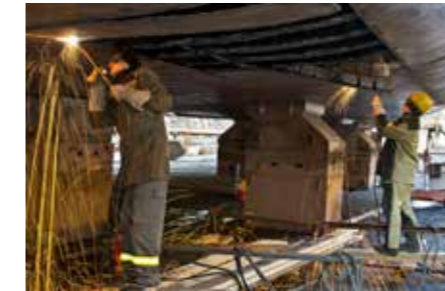
Организация любых судоремонтных работ
