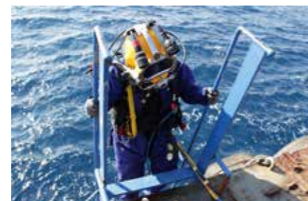
Водолазный осмотр судов, подводный ремонт
