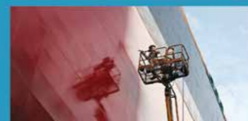
ПОКРАСОЧНЫЕ И ЗАЧИСТНЫЕ РАБОТЫ
