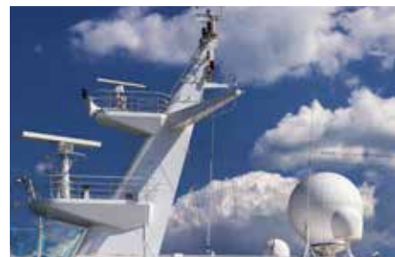
Техническое обслуживание радионавигационного и передающего оборудования
