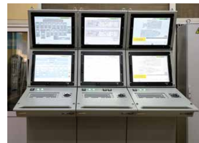
Пульты управления ЦПУ КСУ ТС
