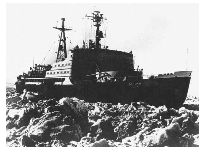
В модернизации ледокола «Ленин» в 1967-1970 годах принимали участие специалисты электромонтажного предприятия
