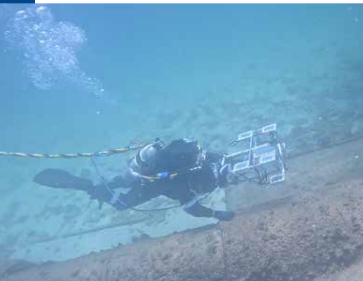
Рис. 3 - Обследование с применением подводного буксировщика и водолаза
