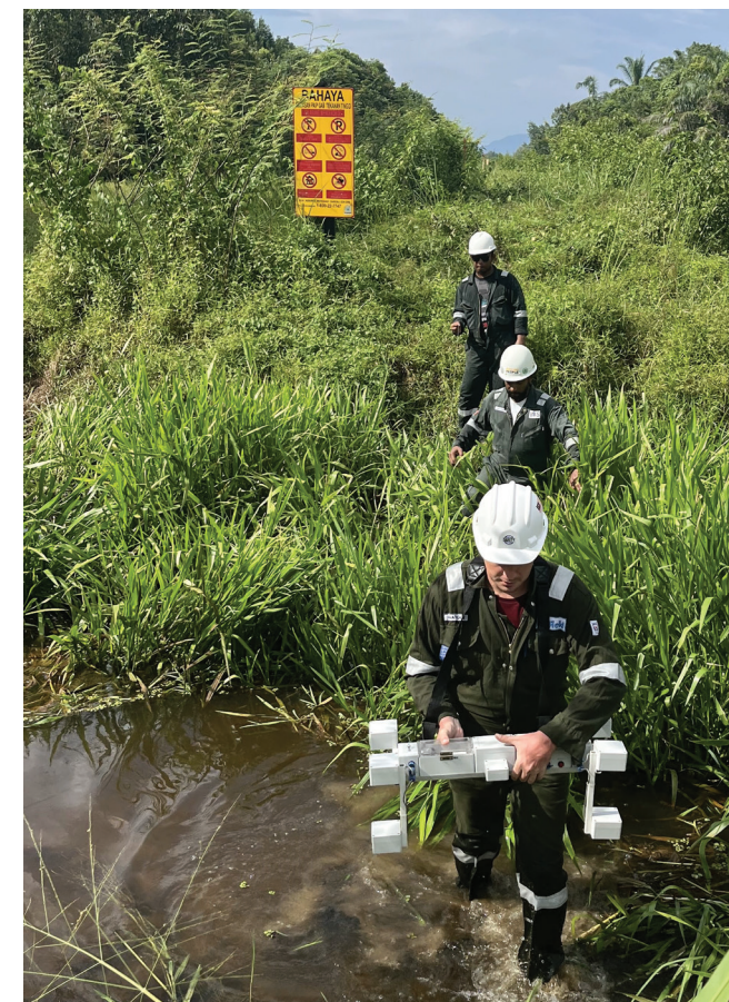
Рис. 4 - Прибрежные и сухопутные участки трубопроводов обследуются магнитометром КОРД в наземном исполнении
