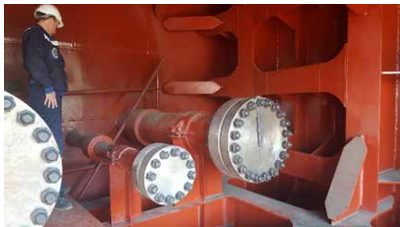
Рис. 4 Примеры конструктивных решений по подводным патрубкам МСП
