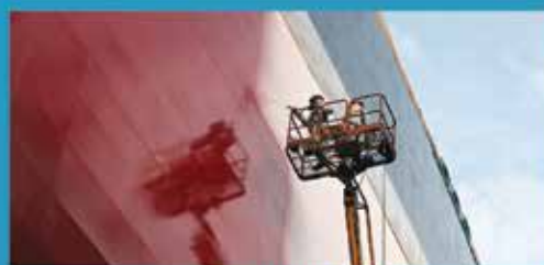
ПОКРАСОЧНЫЕ И ЗАЧИСТНЫЕ РАБОТЫ
