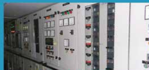
МОНТАЖ И РЕМОНТ ЭЛЕКТРООБОРУДОВАНИЯ
