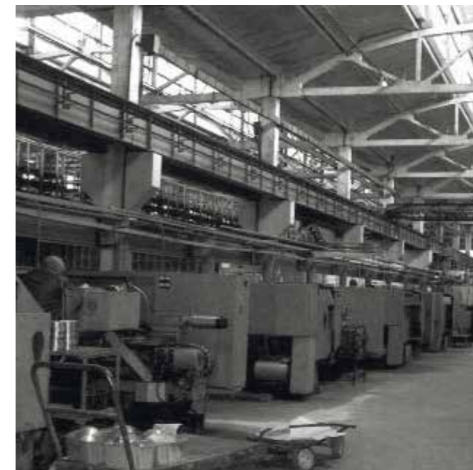
Цех № 13, участок по изготовлению штифтерно-торцевых соединений
