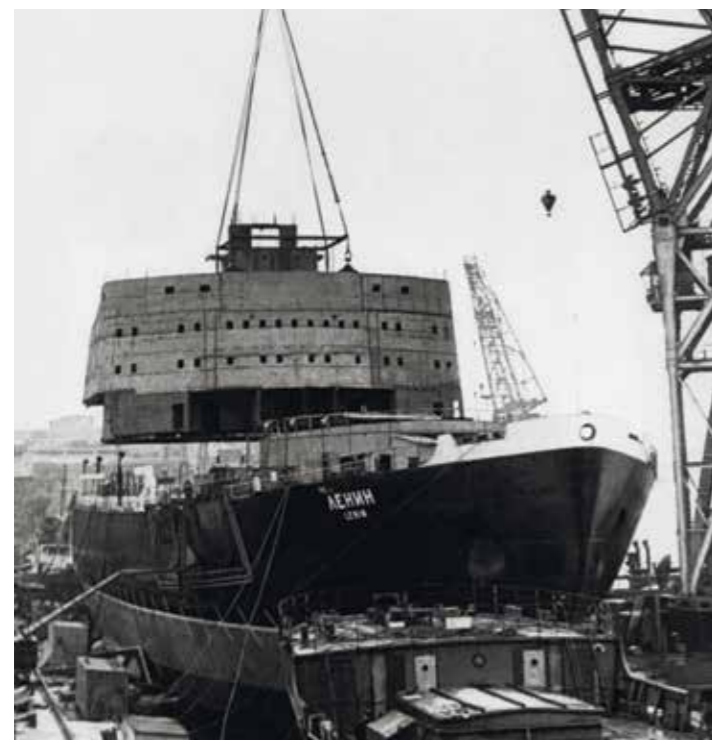
Строительство атомного ледокола «Ленин»
