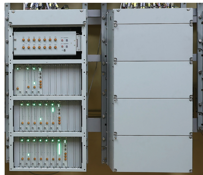
Модульный контроллер в составе локальной технологической станции КСУ ТС
