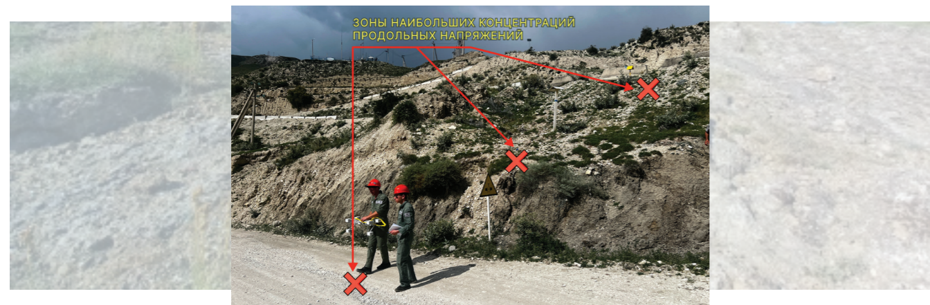
Рис.1. Горный участок газопровода
