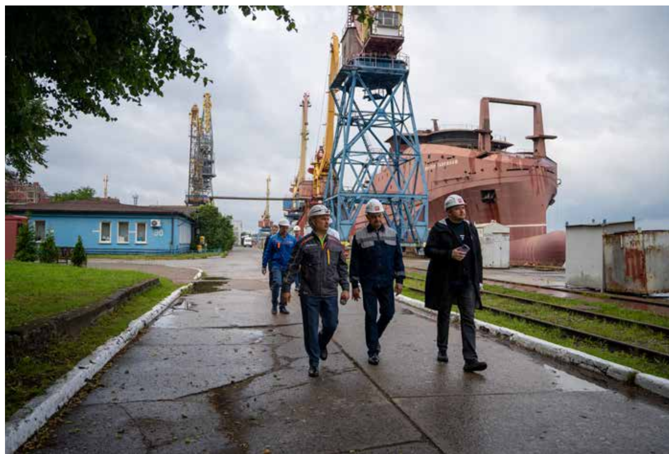
Осмотр хода строительства заказов на достроечной набережной
