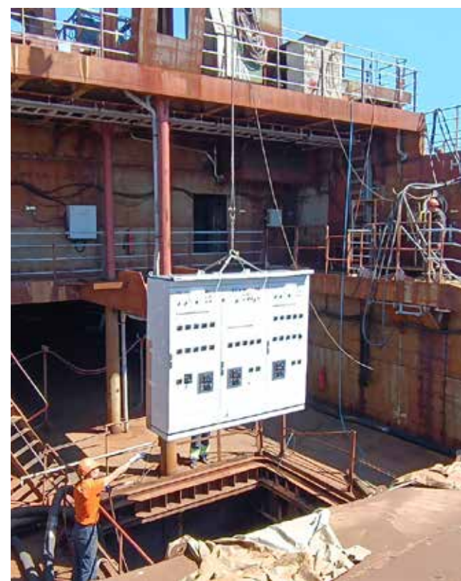
Погрузка главного распределительного щита на борт судна
