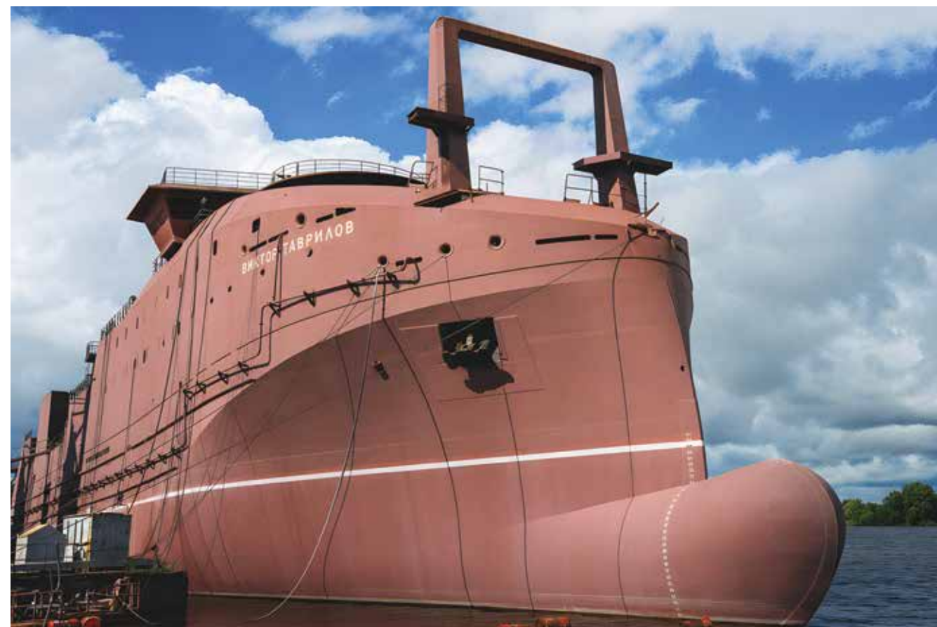
БМРТ «Виктор Гаврилов»: достроечные работы на воде
