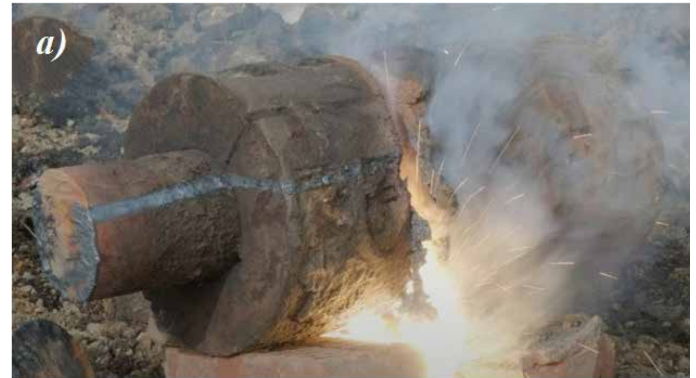
Рис.1. Дистанционная разделительная лазерная резка стального вала переменного сечения. Остров Сахалин, залив Анива, берег бухты Лососей. а) Резка сечения диаметром D_3 .
