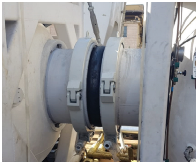
Фото 7. Монтажный комплекс стыковки.
