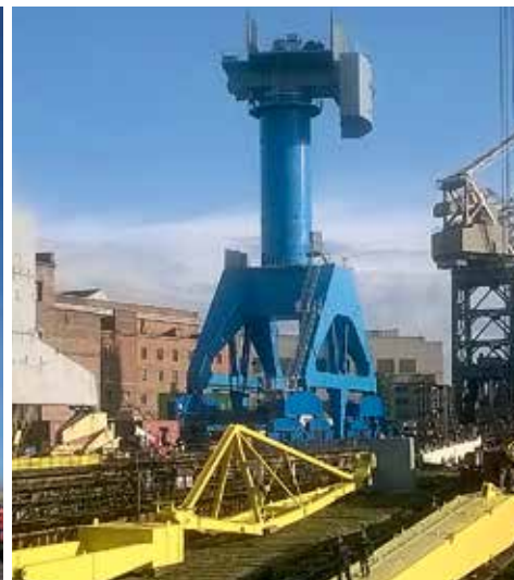
Монтаж крана производства ЗАО «СММ» на ООО «Балтий- ский завод - Судостроение» для постройки самых больших атомных ледоколов в мире (по проекту 22 220)
