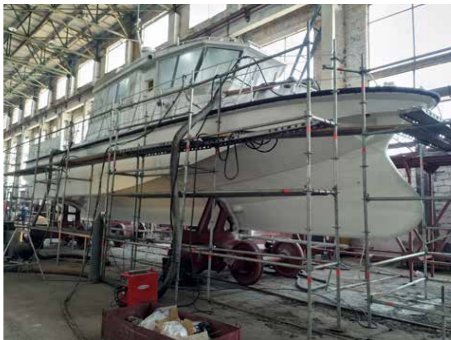
Окраска построенного на стапеле ФГУП «СЗ «Море» корпуса пр. 03550
