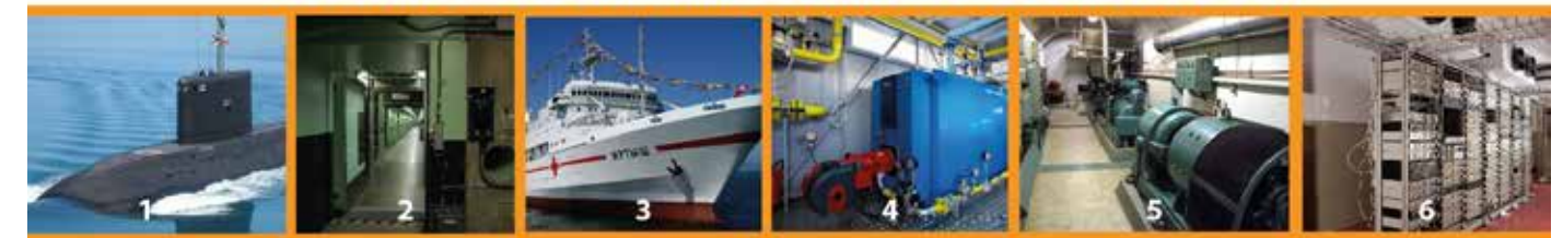
1. Корабли ВМФ 2. Объекты РВСН 3. Госпитали (плавучие) 4. Котельные 5. Генераторные 6. Дата центры и узлы связи
