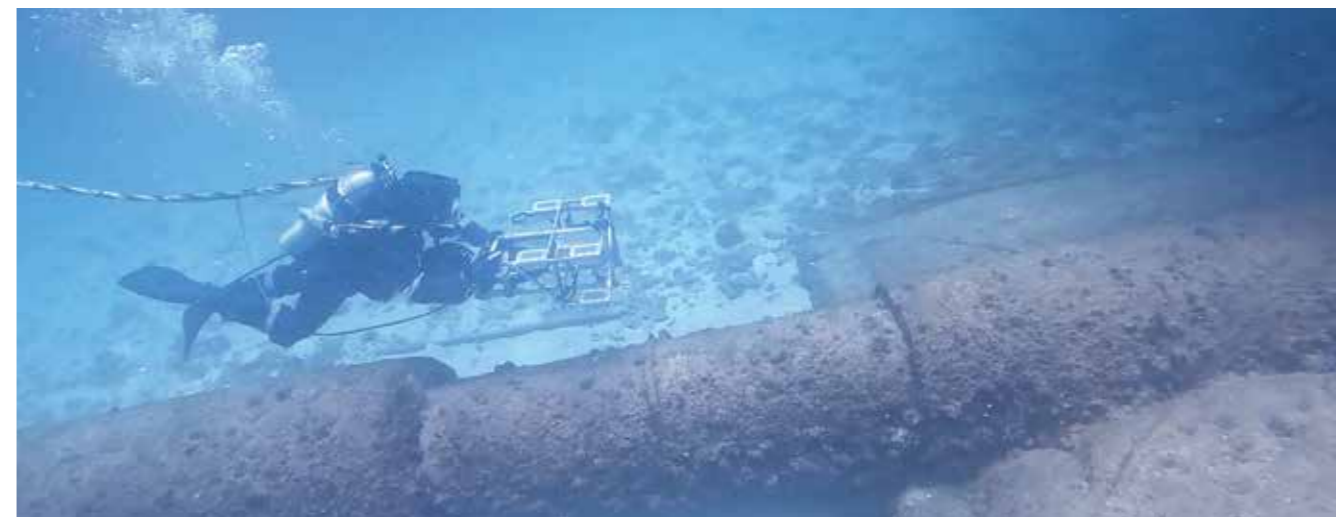
Рис. 5 МТМ-Г обследование 36" газопровода компании ADNOC (ОАЭ, Персидский залив)
