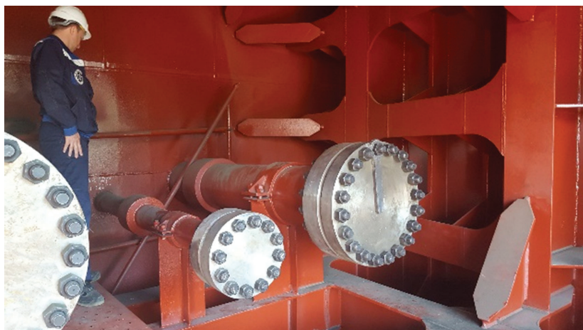
Рис. 4 Примеры конструктивных решений по подводным патрубкам МСП
